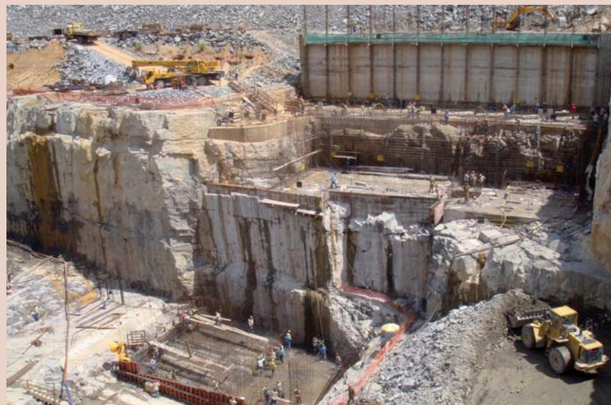
**Casa de Força e Canal de Fuga, que restitui a água do circuito hidráulico que gerou energia para o Rio Paraíba do Sul**
