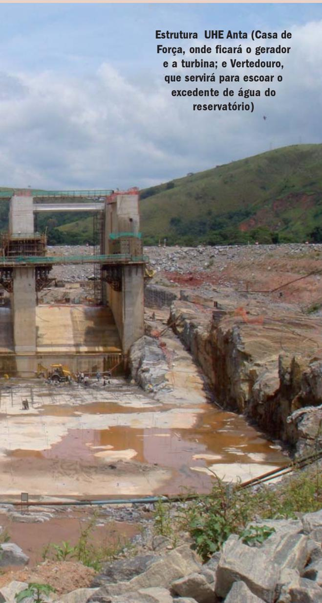
**Estrutura UHE Anta (Casa de Força, onde ficará o gerador e a turbina; e Vertedouro, que servirá para escoar o excedente de água do reservatório)**
