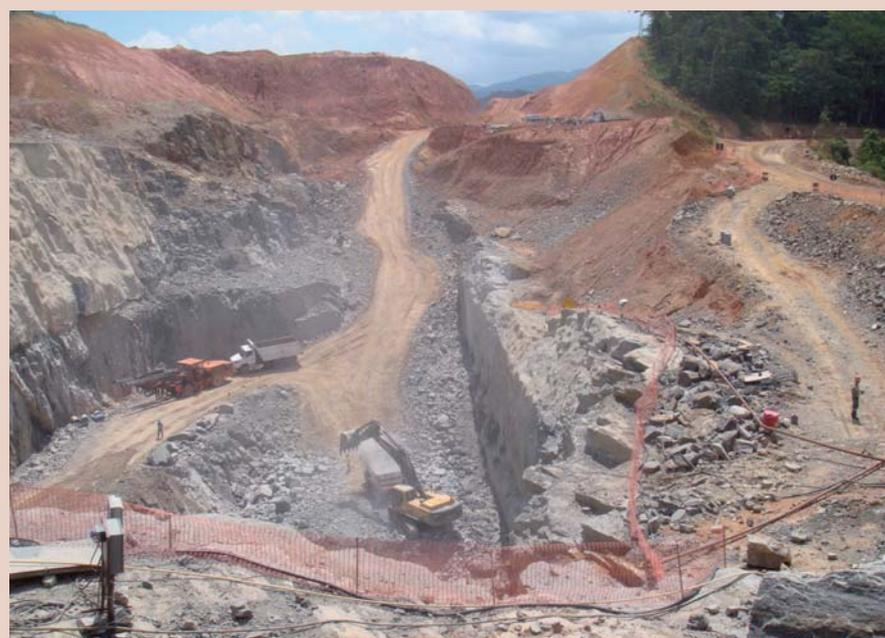
**Construção do Canal de Adução, que vai interligar o Reservatório Peixe à Tomada D'água, que direcionará a água dos Túneis de Adução até as turbinas**
