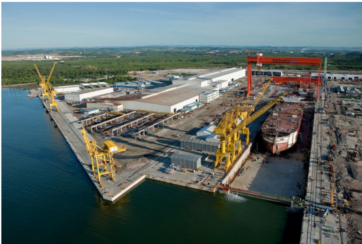
Estaleiro Atlântico Sul – Suape (PE)
