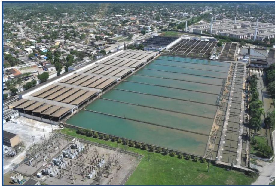
Abastecimento de água
